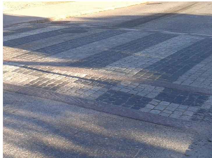
Kuva 4. Esimerkki korotuksesta, joka on erotettu asfaltista luonnonkivellä.
