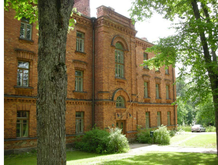
Kuva 1. Alueen olemassa olevaa rakennuskantaa.
