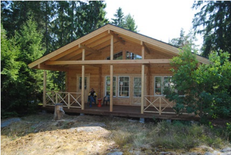
Kuva 20. Valmistumaisillaan oleva päärakennus.
