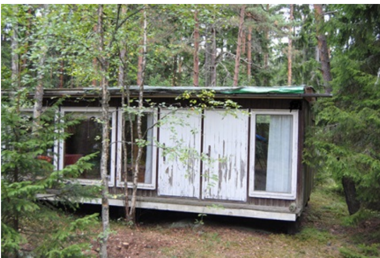
Kuva 16. Peruskorjaamaton päärakennus odottaa vuoroaan.
