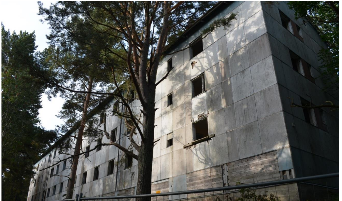
Kuva 11. Jussarön saarelle rakennettiin 1950-luvulla asuinrakennuksia kaivostyöntekijöille. Rakennukset ovat nykyään hylättyjä ja eristetty aidoin. (Kuva FCG 2014)
