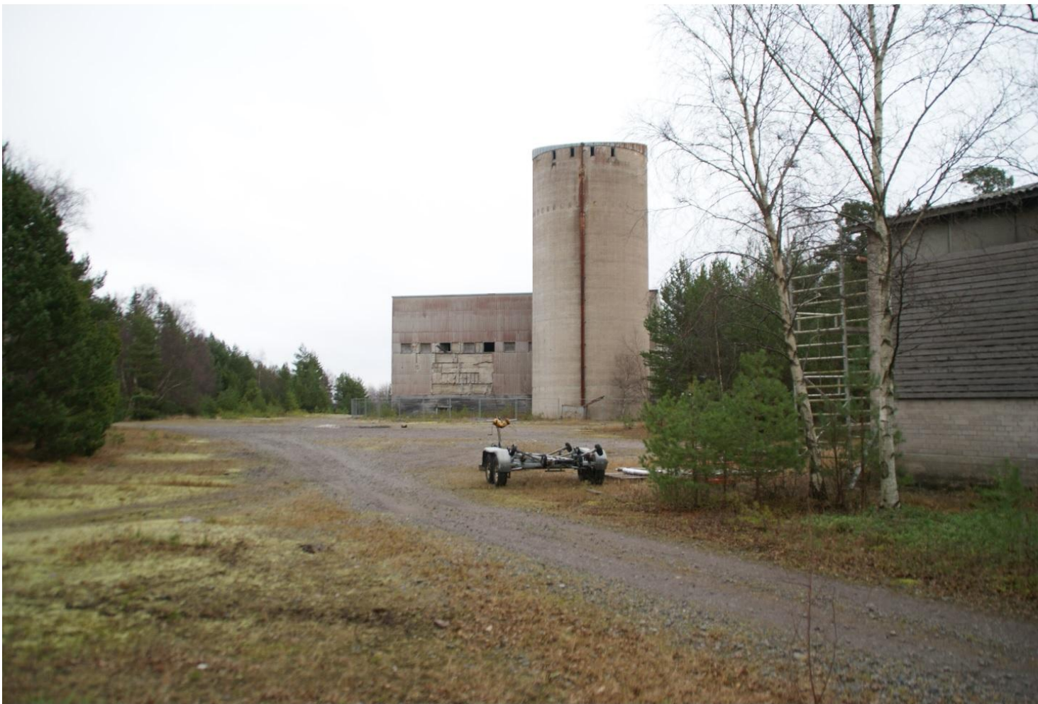
Konttorin, vesitornin ja verstasrakennuksen muodostama rakennuskokonaisuus
