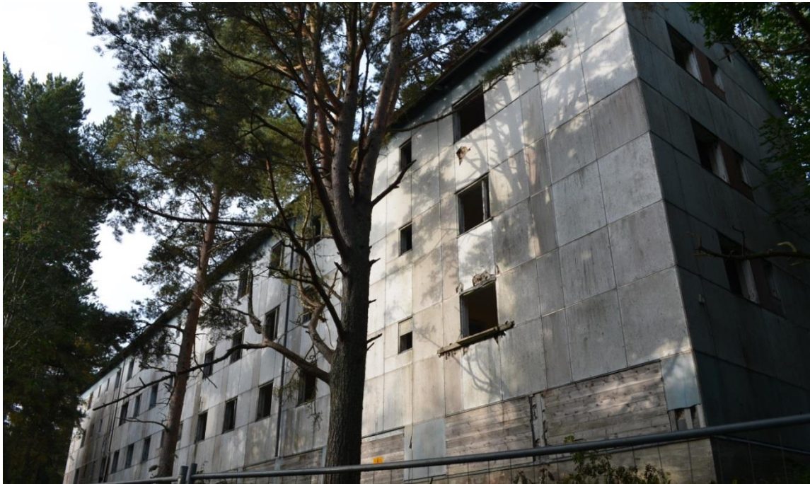
Kuva 11. Jussarön saarelle rakennettiin 1950-luvulla asuinrakennuksia kaivostyöntekijöille. Rakennukset ovat nykyään hylättyjä ja eristetty aidoin. (Kuva FCG 2014)
