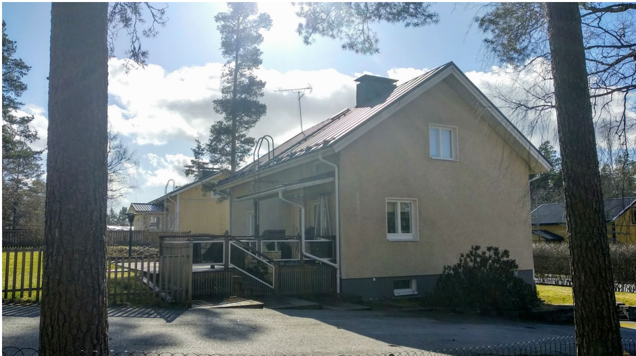
Kuva 4. Trollbergintie 3. Rapattu asuinrakennus, ulkoisesti suhteellisen alkuperäisessä kunnossa.
