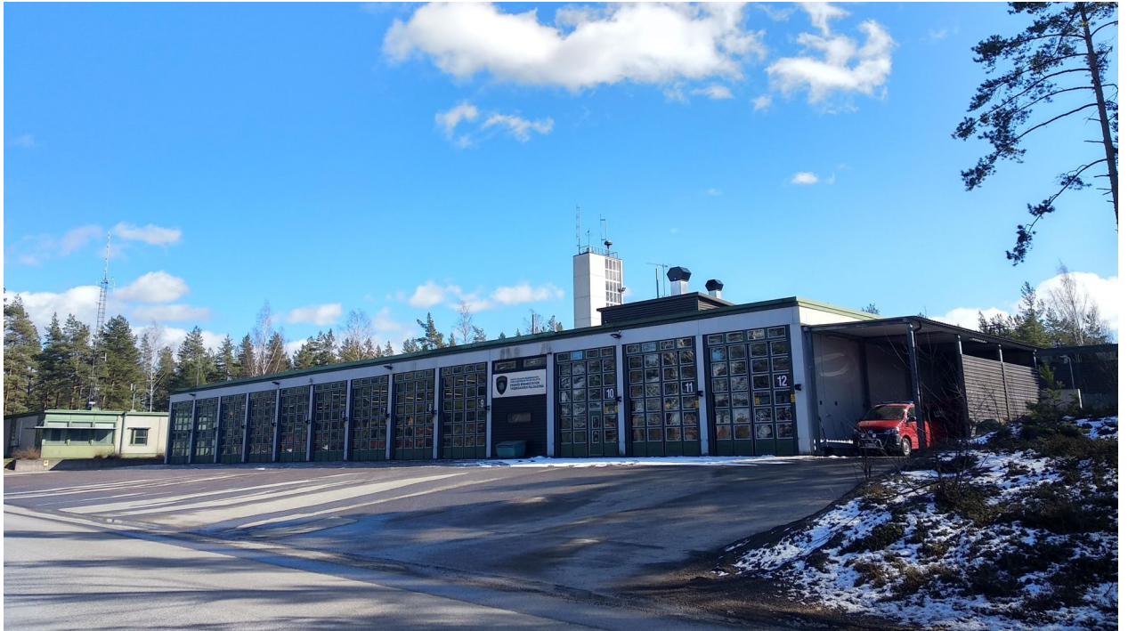
Kuva 2. Tammisaaren paloasema, Oikotieltä katsottuna.
