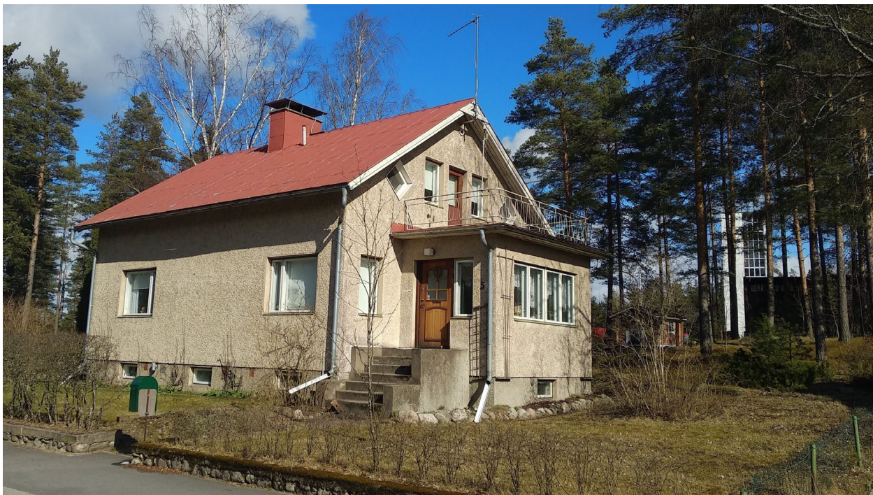
Kuva 5. Trollbergintie 5. Rapattu asuinrakennus, ulkoisesti suhteellisen alkuperäisessä kunnossa.
