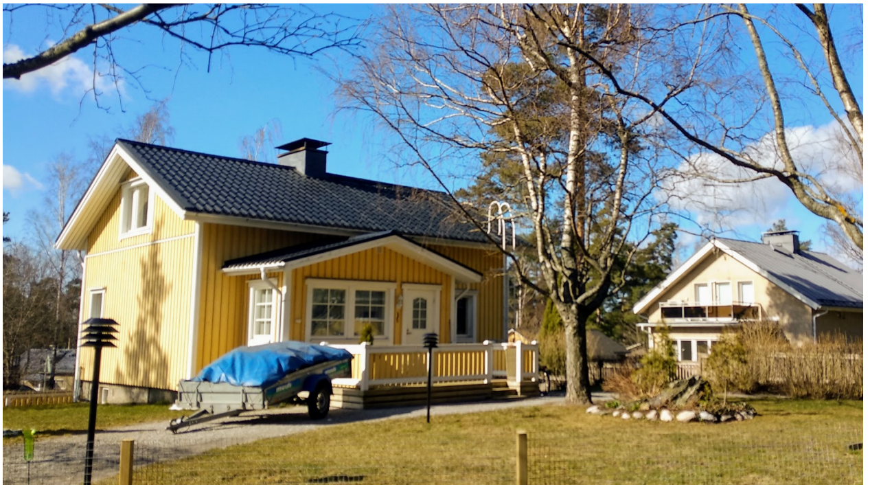
Kuva 3. Trollbergintie 1. Lautoitus, kattomateriaali ja ikkunat on vaihdettu, ja asuntoa on laajennettu vuonna 2002.
